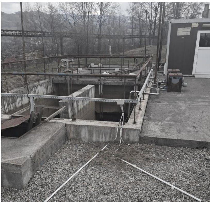
Stație de epurare ape – E.M. Vulcan
